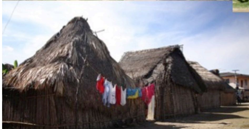
Les maisons traditionnelles construites en bois de mangrove et en feuilles de palmier
